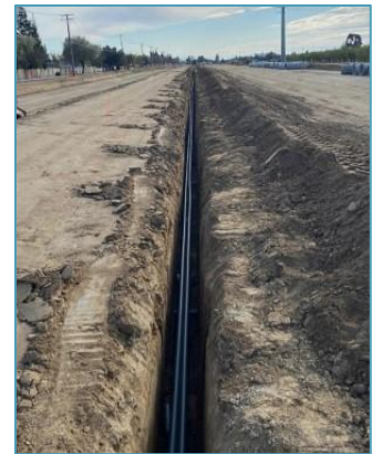
Fiber Optic Conduit Installation
